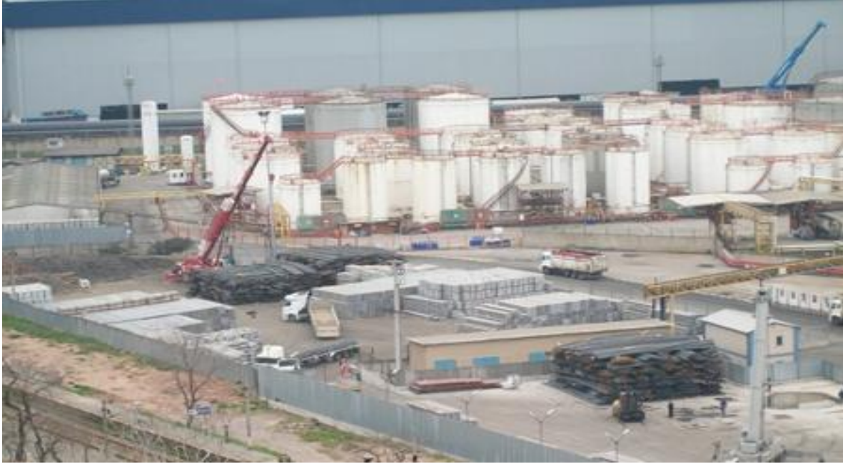
Şekil 3 Tesisin Dış Görünüşü 2
